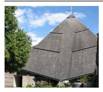
Mittlerweile ist es schon zwei Jahre her, dass die Heilig-Geist-Kirche in Breitbrunn geschlossen werden musste. Hintergrund war eine Überprüfung der Tragkonstruktion des Zeltdaches. Dabei wurde festgestellt, dass dort ein harnstoffhaltiger Holzleim verwendet wurde, der bei anderen Bauwerken zu statischen Einschränkungen und bei der Eissporthalle in Bad Reichenhall auch zu einem Versagen der Konstruktion geführt hat.
